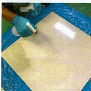
施工面をガソリンで洗浄
